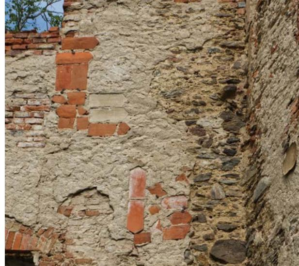
↑ Nördliche Hofmauer: Z. T. von Metallklammern gehaltene Dachziegel, sogenannte Bischofsmützen, als Basis für eine barocke Verputzung. Rechts davon kleinteiliges, mittelalterliches Bruchsteinmauerwerk
